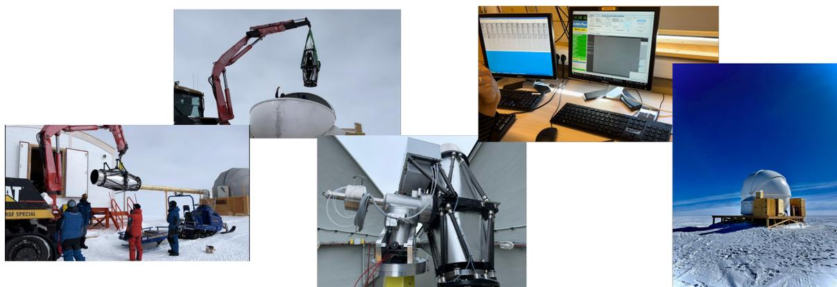
Figure 1 : Installation du télescope ASTEP et sa nouvelle boîte caméra dans un nouveau dôme d'observation à Concordia. L'image de l'ordinateur montre la première lumière obtenue le 27 décembre 2021. [Crédits : IPEV/PNRA/ASTEP]
